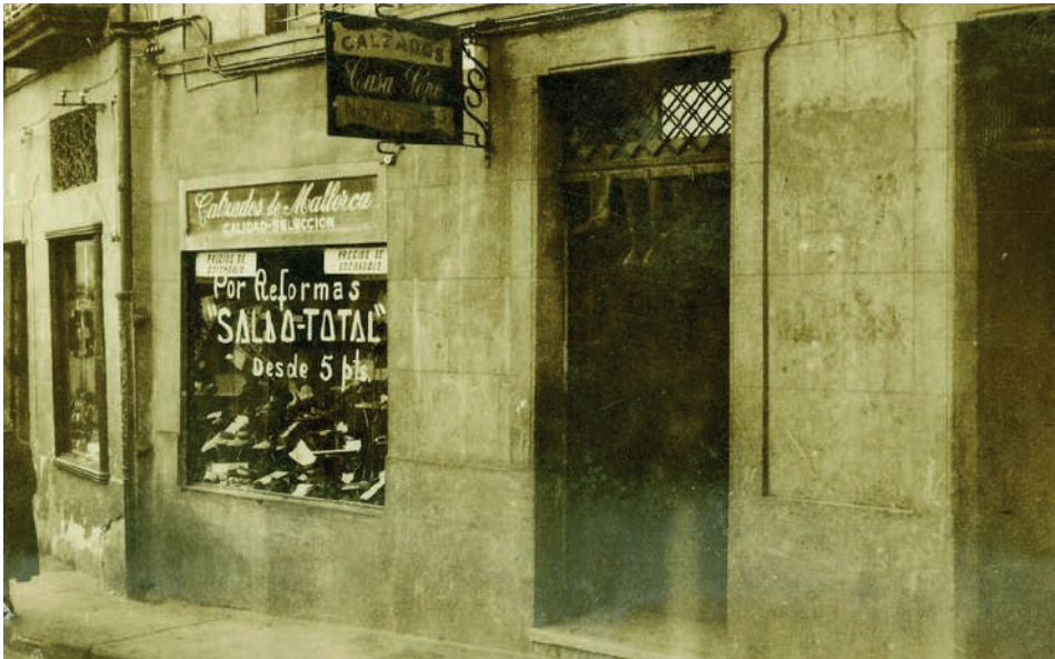
Fotografía da fachada que pretendía reformar José Granero Lagoa para construír dous escaparates no número 45 da rúa Travesa (AMB c.642_106)
