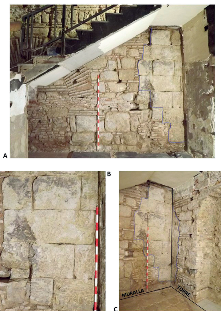
Fig. 2: Muralla republicana documentada en c/ Alfaros 33. A. Imagen de la muralla, en la que se aprecia tanto la fábrica romana como la reforma de los siglos XVII-XVIII. B. Detalle de la edilicia de la fábrica romana. C. Detalle del arranque de la torre republicana.
