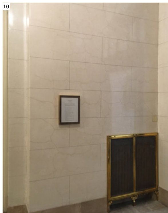
Figura 11: Detalle de los paramentos estucados de la galería principal del Banco de España, 2022
