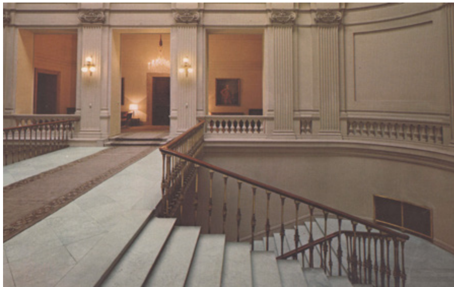
Figura 12: Escalera del Banco de España en 1970. No hay rastro de los estucos a la plancha históricos y la tonalidad y la homogeneidad de los paramentos y relieves se corresponden con los del estado actual (Banco de España 1970)
