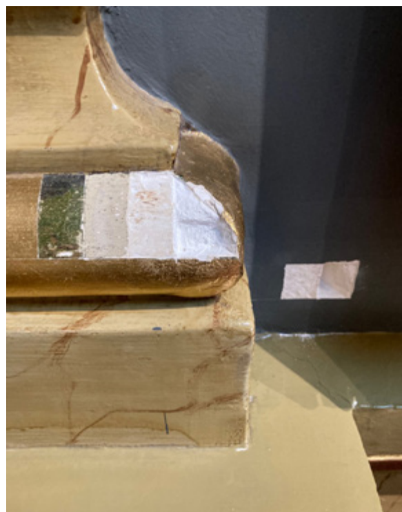
Figura 4: Cala estratigráfica realizada en 2022 en el Senado, Madrid, en busca de los acabados históricos del edificio (Luis Prieto)
