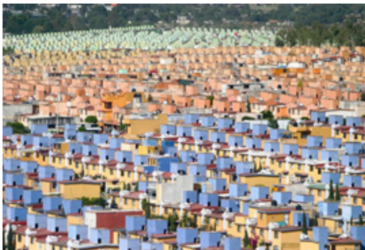
Figura 2 Casas producidas en masa, con diseños genéricos que el usuario debería poder apropiarse y construir comunidad. Fuente: López, 2021.
