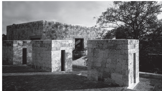
Imagen 4. Casa de Huéspedes Ilustres: Recorrido sobre las cubiertas.
