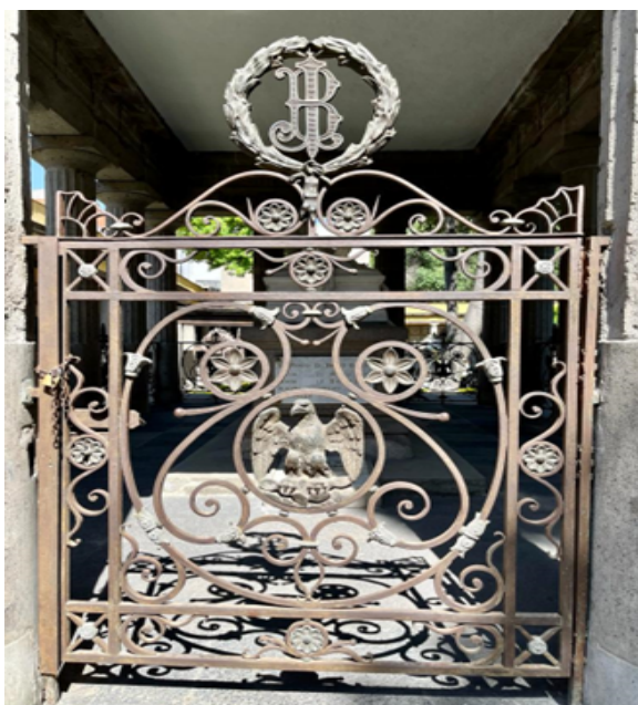
Fig. 5. Segmento de de uno de los paneles de la cerrajería perimetral. Fotografía: autor (2022).
