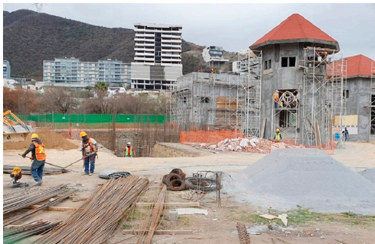
Fig. 16. Museo La Milarca en construcción. 2021. San Pedro Garza García (Nuevo León, México). Foto El Norte (Monterrey)
