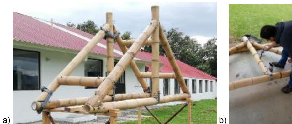
Figura 3. Proceso de montaje de la cercha. a) Montaje del experimento b) aplicación del lasur con brocha con y sin lijar la superficie.
