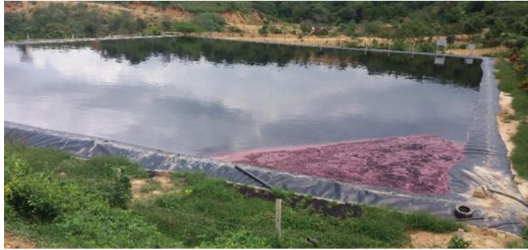
Figura 2. Piscina de almacenamiento totalmente llena de lixiviados.
