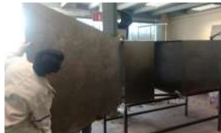
Fig. 4. Construcción de estructura metálica
