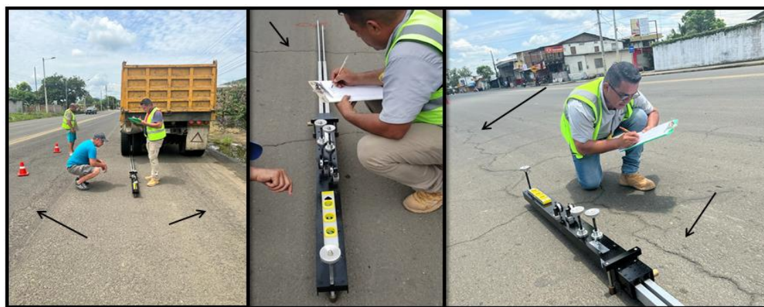
Figura 4. Deterioros encontrados en el tramo de estudio.
