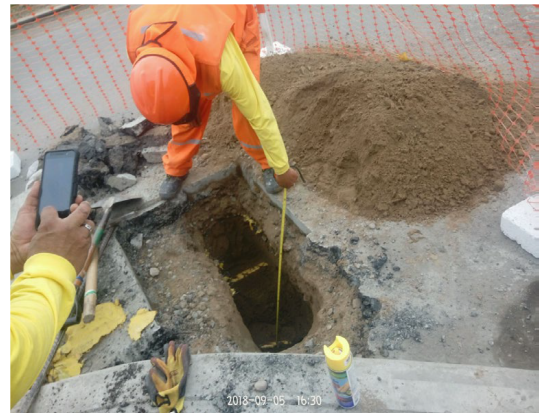
Figura 1. Construcción, demolición y excavación de zanjas [8]
