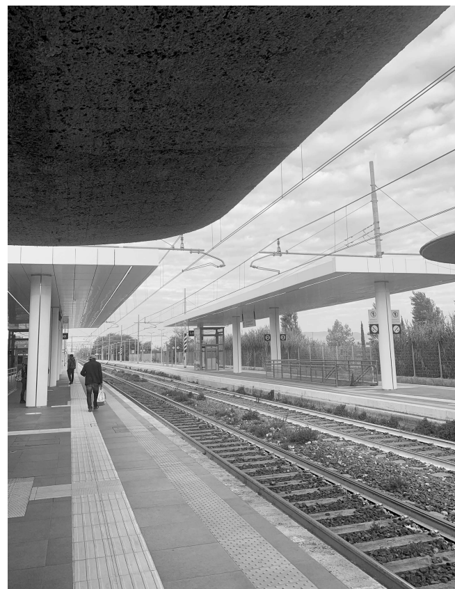
Fig. 22. Stazione di Latina, le nuove pensiline standardizzate.
