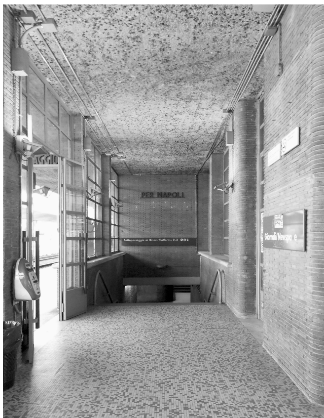
Fig. 21. Stazione di Latina, l'accesso al sottopassaggio. Si noti la policromia delle pavimentazioni in tessere di gres ceramico e il soffitto in c.a. lavorato a scalpello con inerti vitrei (foto del 2012).
