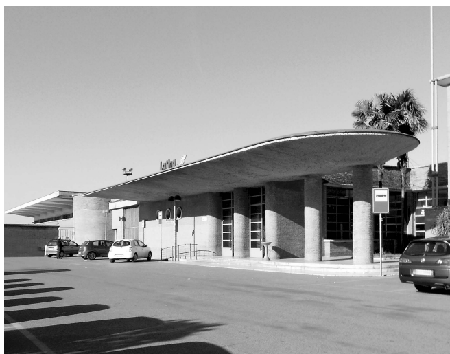
Fig. 16. Stazione di Latina, prospetto sul piazzale (foto del 2012).
