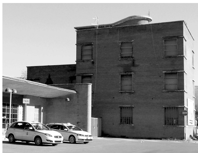
Fig. 17. Stazione di Latina, edificio per abitazione per sei famiglie (foto del 2012).
