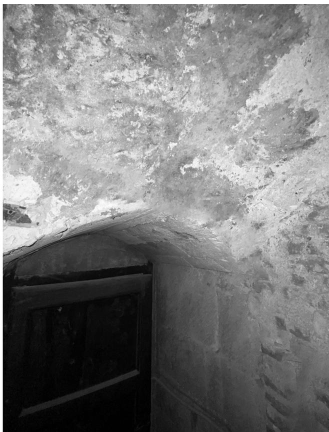
Fig. 11. Attacco imbottito ingresso-volta scala A.
