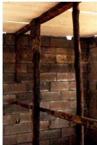
Figura 8. Apuntalamiento de la prelosa.
