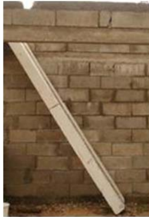
Figura 7. Inclinación de la prelosa para el montaje
