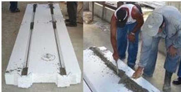
Figura 5. Hormigonado de las viguetas
