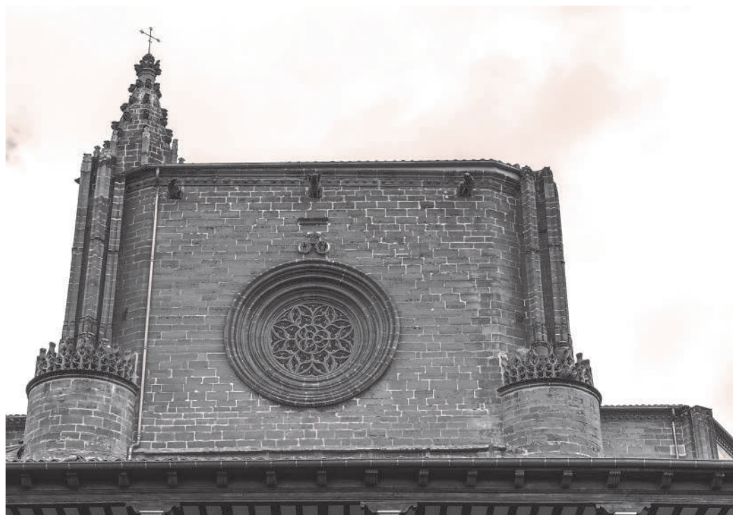
Cresterías junto al rosetón del transepto meridional, vistas desde el claustro.
