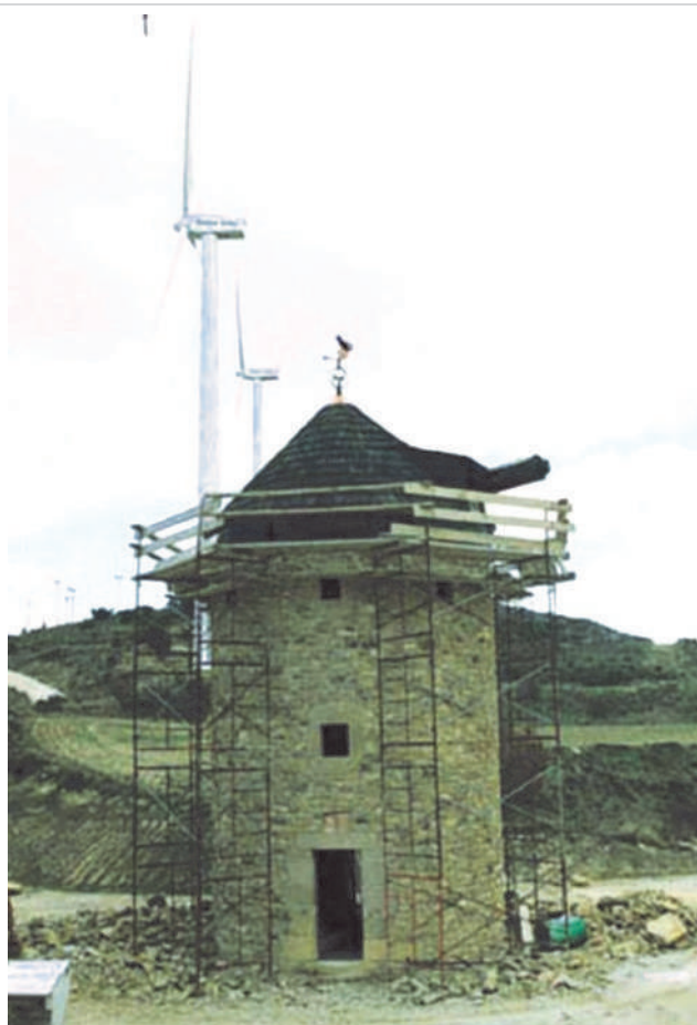
Construcción del molino.
