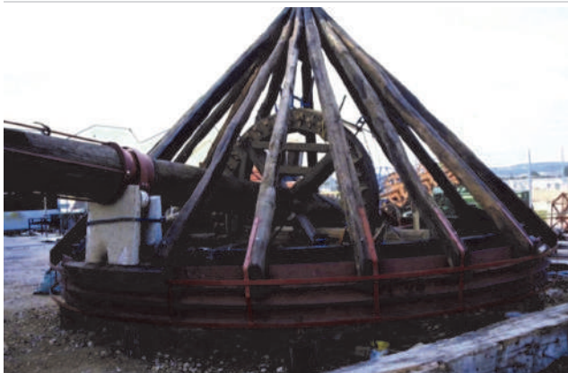
Parte giratoria con el eje y la rueda catalina.
