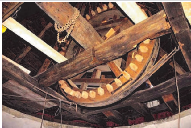
Rueda catalina y eje principal del molino.
