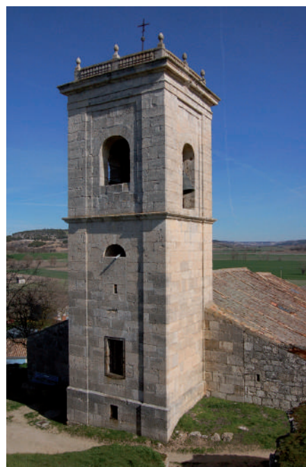
Fig. 2. Vista de la torre de Canillas desde el Suroeste.
