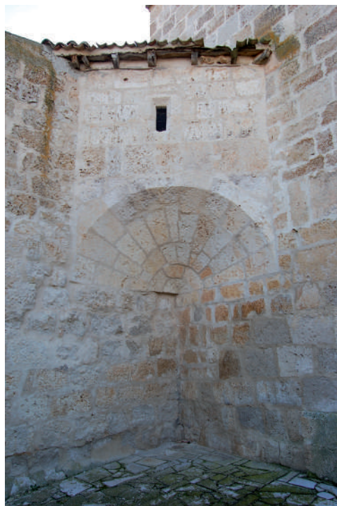
Fig. 28. Pasillo de ingreso en la torre de Encinas desde el coro de la nave del Evangelio, apoyado sobre una trompa.
