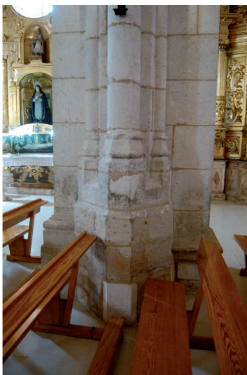
Fig. 10. Pilar tardogótico adosado a una pilastra en la nave central del templo que correspondería al arco triunfal del primitivo edificio parroquial.
