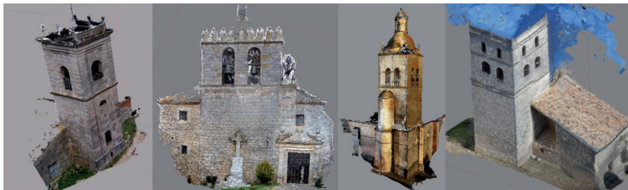
Fig. 1 Modelos fotogramétricos tridimensionales de las torres estudiadas obtenidos mediante el programa Agisoft MetaSahape.
