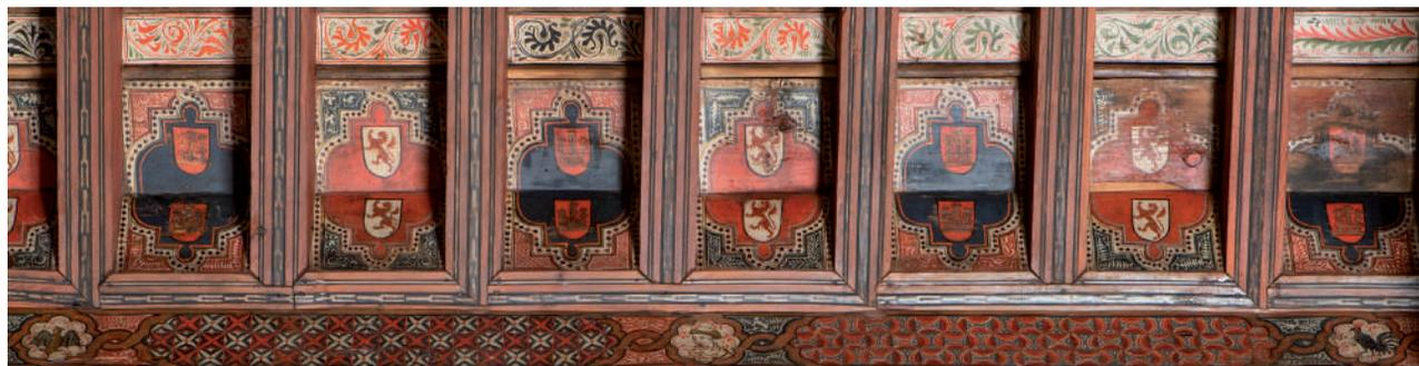
Ilustración 15. Cinta del almarbate que alterna de romo a agudo.
