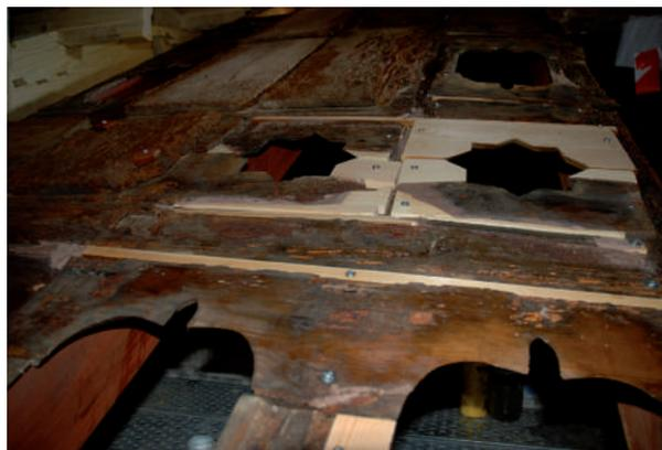
Ilustración 9. Reverso de la labor de menado formada por cintas recortadas con forma de arco conopial y saetinos laterales.
