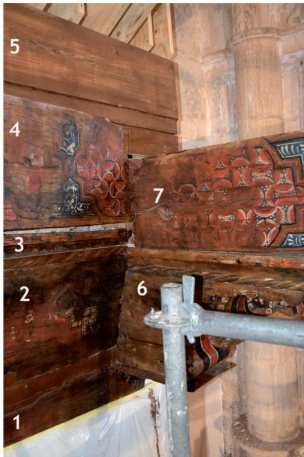
Ilustración 11. Piezas del acuesto de la armadura de Sinovas. 1.- Solera; 2.- Alicer bajo; 3.- Tocadura; 4.- Alicer alto; 5.- Estribo; 6.- Can; 7.- Tirante.
