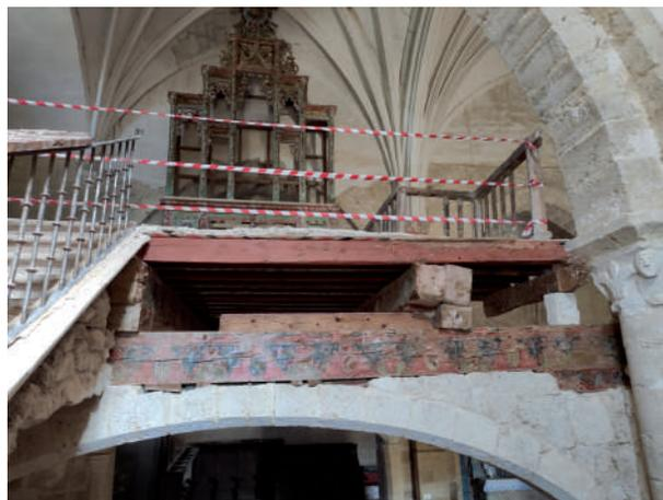
*Ilustración 4. Lateral del alfarje de la iglesia de San Millán en Los Balbases donde se aprecian que existen piezas anteriores reutilizadas (Burgos).*
