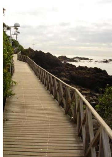
Foto 2: Percurso por deck sentido pontal norte /praia do buraco
