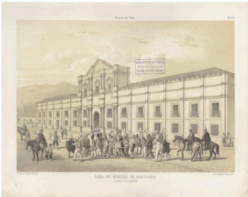
**Figura 6** Casa de Moneda con la supresión de los remates, del antepecho del cuerpo central y el reemplazo de los balaustres por tableros duros, de Lehnert (1854). Fuente: Guarda (1997, p. 203).
