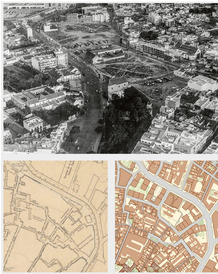
Figura 3. Foto del solar resultado del proceso de demolición y planos de la trama urbana antes y después de la operación de San Julián
