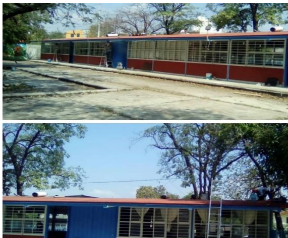
Figura 1. Mantenimiento de techos y pintura de Áreas
