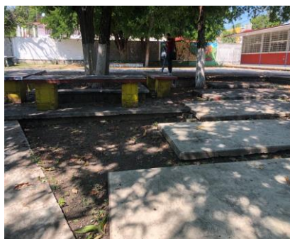
Figura 2. Desniveles mal planeados en los patios. Fuente: Propia
