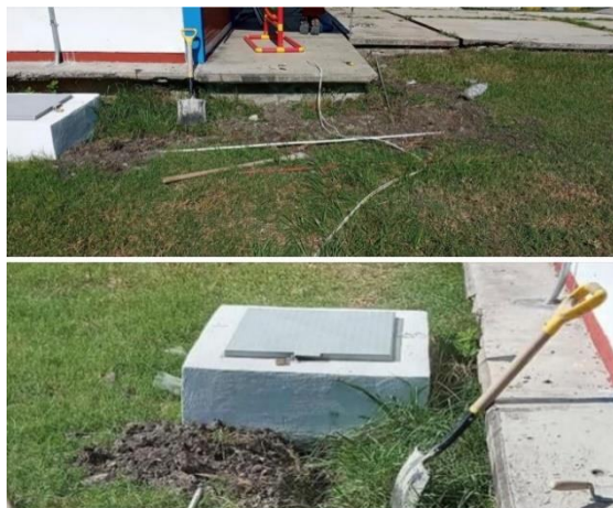
Figura 2. Mantenimiento a las Instalaciones
