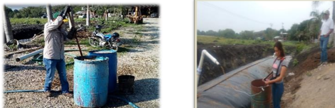
Figura 1. Preparación de la mezcla y alimentación al biodigestor para la producción del biol en campo
