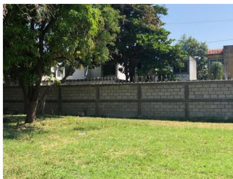
Figura 6. Barda Perimetral con concertina. Fuente: Propia
