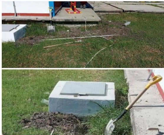
Figura 2. Mantenimiento a las Instalaciones
