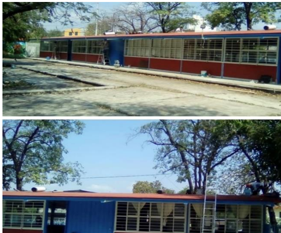
Figura 1. Mantenimiento de techos y pintura de Áreas
