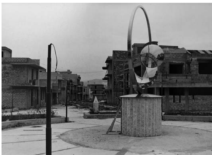
Fig. 6. Gibellina Nuova, en la fase de construcción. En el primer plano aparece la pieza "Ritmi spaziali" de Carmelo Cappello (1979). Fotografía: Mimmo Jodice.
