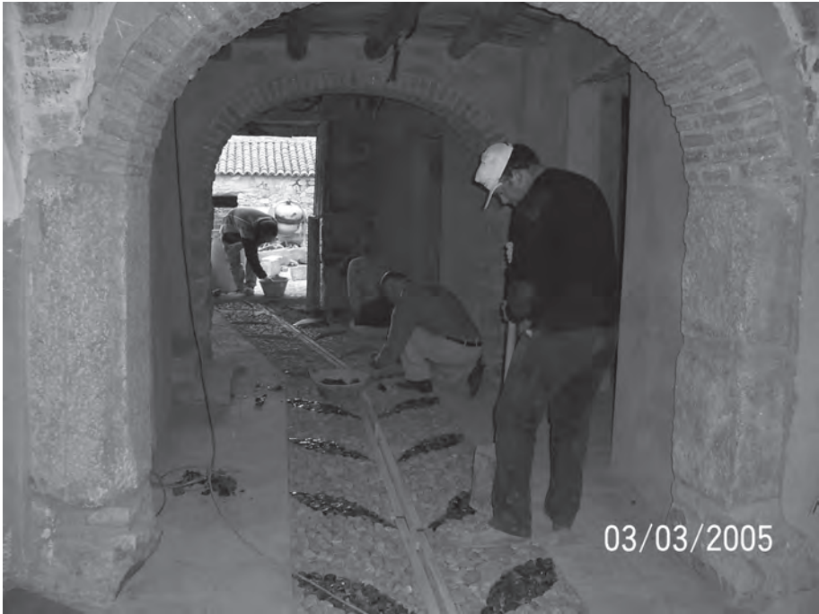
Trabajos de restauración y puesta en valor.
