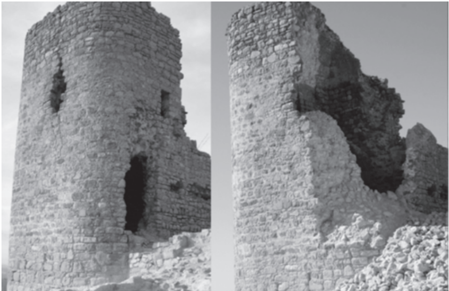
Lám. 1: Estado de la Torre del Homenaje a la toma de datos (2009) y su estado posterior al derrumbe (2011). (Fuente: Porcuna D. 2009-11).
