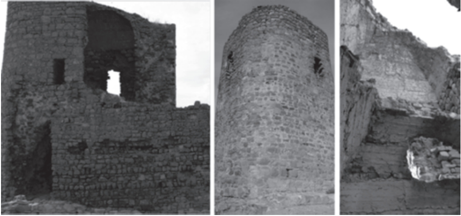
Lám. 2: Torre del Homenaje. (Fuente: Porcuna D, 2009).
