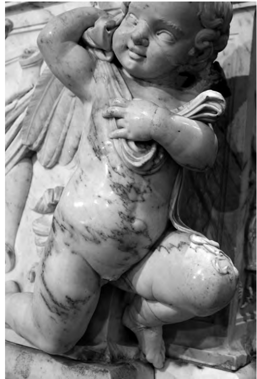
Imatge 15: Vista d'un dels àngels del basament on es pot observar la transformació dels minerals existents al marbre, la qual es manifesta amb la formació de taques i de petits glòbuls exsudats (foto: P. Arroyo).
