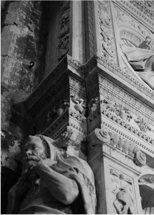
Imatge 8: Vista d'un cantó del sepulcre on s'observa la junta vertical existent, la qual només és visible en la posició que mostra la fotografia (foto: P. Arroyo).
