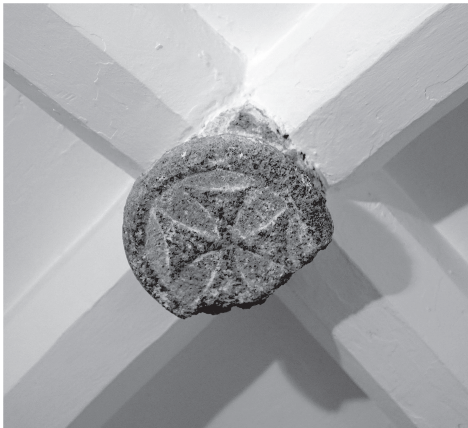
Foto 12.- Clave de una de las bóvedas
