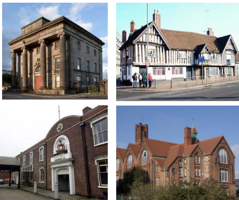
Fig.12. Edificios protegidos. Arriba, estación Curzon Street y antigua casa consistorial. Abajo, Gun Barrel Proof House y la escuela de Floodgate. Fuente: www.wikipedia.org , www.geograph.org , www.birminghammail.co.uk y www.britishlistedbuildings.co.uk , respectivamente.
