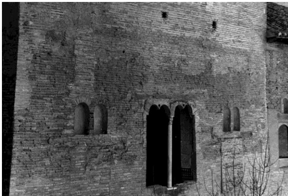
Fig. 1. Exterior del Mirador del Cuarto Dorado (obsérvense las ventanitas de medio punto cegadas y la correspondencia de la parte superior del arco gótico con las que hubiera en la zona central del muro). Detalle de una fotografía de Armando Antonio López Murcia fechada en 1965. Fuente: Archivo Histórico de la Alhambra. Colección de Fotografías, F-020181
