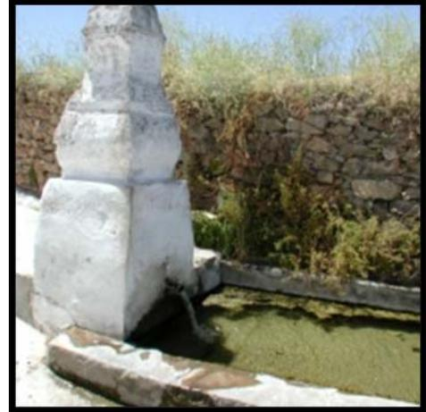
**Figura 3.** Fuente de la Machona en Malcocinado. Se observa que se sitúa bajo el nivel del suelo, con gradas de ladrillo y piedra para descender a los caños y facilitar el abastecimiento de agua al ganado.
