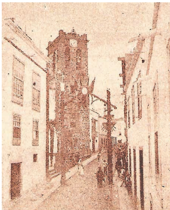
Casa Monteverde, fachada a calle Real
