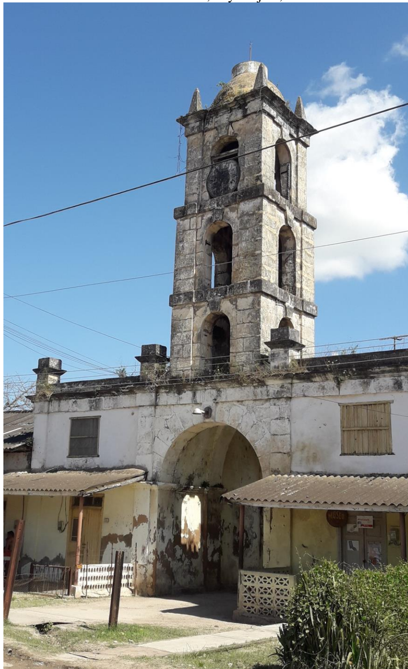
Figura 2. Torre del barracón de la central Álava, hoy Méjico, con la entrada a la sala museo
