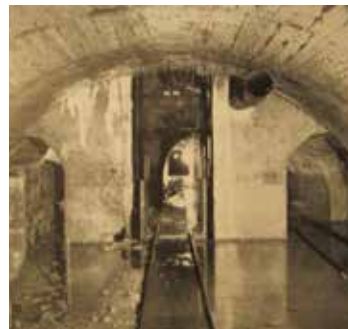
Socavón, en el Pozo 4 (1958).
