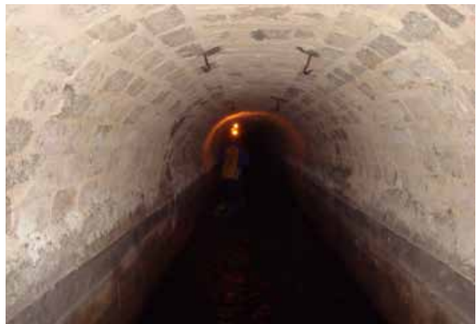
Revestimiento del socavón en las zonas de margas y areniscas.
