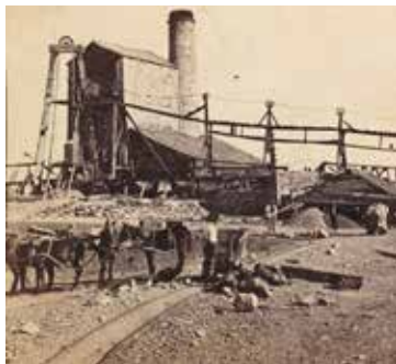
Pozo Santo Tomás (Pozo Ancho).
