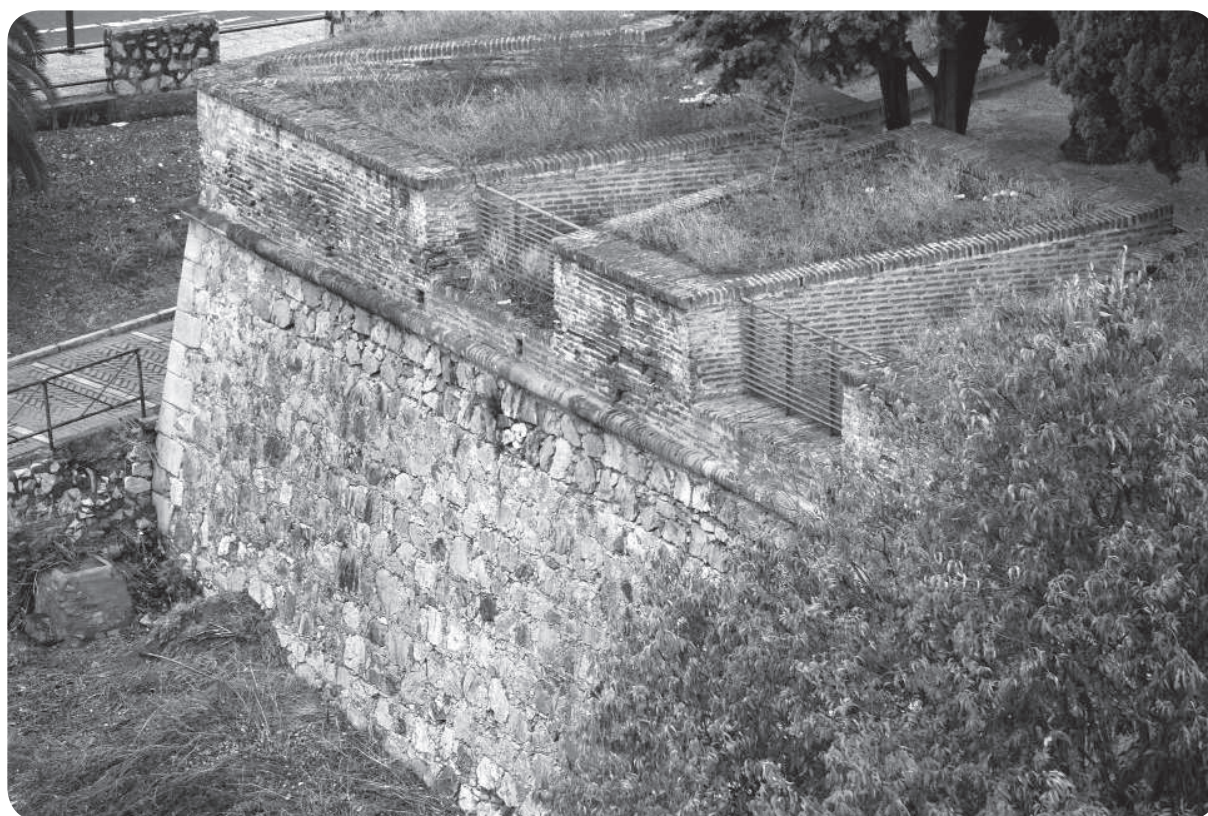
Foto nº 10: Baluarte de Puerta Palmas
