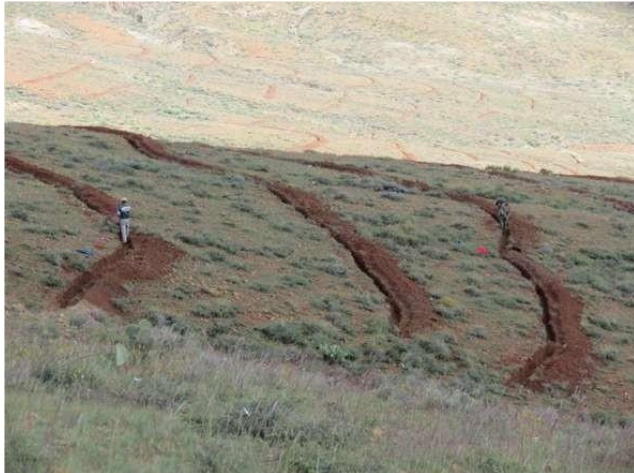
Figura 14. Vista de zanja-bordo, caso 3. Fuente: CONAFOR, 2015.
