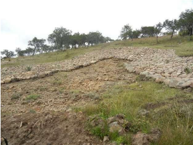
Figura 11. Cabeceo de cárcavas, caso 2. Fuente: Elaboración propia.
