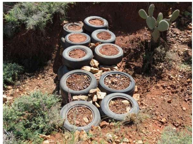
Figura 13. Presa de llantas, caso 3. Fuente: CONAFOR, 2015.
