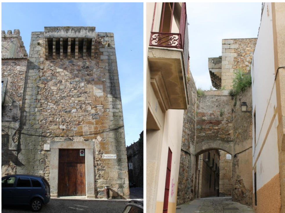
Fig. 11. Torre esquinera del Palacio de los Golfines de Arriba, con matacán, en su vista intramuros y extramuros.
