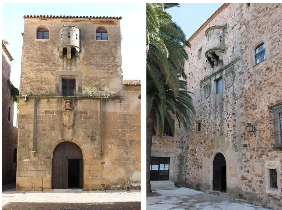
Fig. 14. Fachadas de la Casa del Sol y del Palacio de la Generala, con matacán de tambor semicircular.
