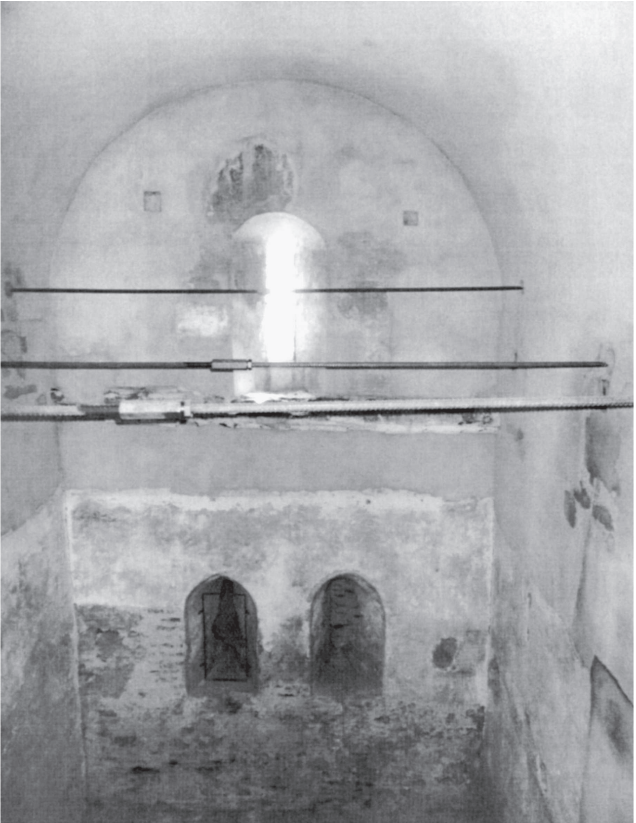
Fig 27.- Pared oeste de la “cripta”. En primer término los tirantes dispuestos para consolidar la estructura. Debajo de la aspillera superior se aprecia una conducción de desagüe, quizá procedente en su día de la cubierta de la capilla mayor. Bajo ella, las dos aspilleras descubiertas tras las catas paramentales
