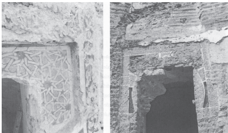
Fig. 18.- A la izquierda, albanega o enjuta de un arco de herradura enmarcado en alfiz en la que ha aparecido decoración de lazo. Este arco se sitúa en la pared interior del ábside de la Capilla Mayor y comunica con la sacristía. A la derecha fotografía del arco antes de las obras de restauración
