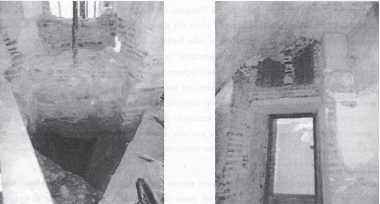
Fig. 8.- A la izquierda, en el suelo se aprecia la cata arqueológica que dejó al descubierto un fragmento del zócalo de granito dispuesto en la parte baja de la antigua fachada del ábside de la Capilla Mayor. A la derecha puede observarse la parte inferior de la ventana nervada. El hueco situado bajo ella corresponde al vano practicado posiblemente en el siglo XIV para acceder al interior del ábside desde la sacristía. A ambos lados de la ventana se aprecian sendos contrafuertes de sección rectangular salientes del plano de la ventana gótico-mudéjar
