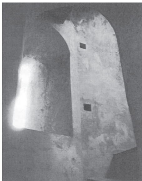
Fig. 17.- Detalle de la torre-escalera una vez concluidas las obras, y de una de las aspilleras que estaban cegadas
