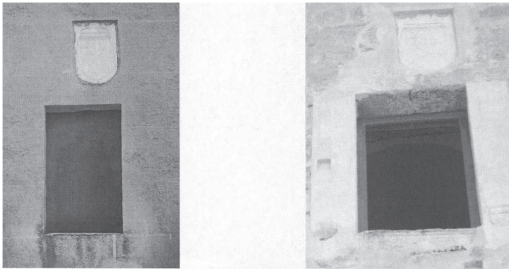
Fig. 16.- A la izquierda, ventana de la dependencia situada sobre la sacristía antes de las obras. A la derecha, la misma ventana después de la intervención. Al eliminarse el revestimiento cementicio salieron a la luz la pilastra visigoda utilizada como alféizar y –a la derecha–, un fragmento de la pilastra que debió romperse cuando se ensanchó el hueco en el siglo XIX
