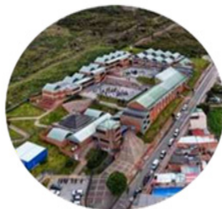
Fotografía 2: imagen detallada del Colegio San Cayetano, IED
