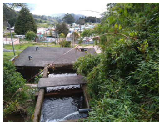
Fotografía 5: acueducto veredal, sector Las Violetas
