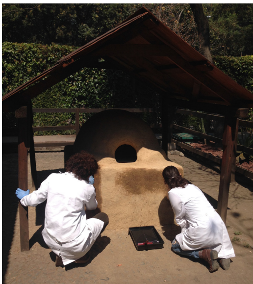
Figura 2: Aplicación de revoques de tierra estabilizada con mucílago de Opuntia durante la restauración en un horno patrimonial en el Museo Nacional de Antropología e Historia de la Ciudad de México.
