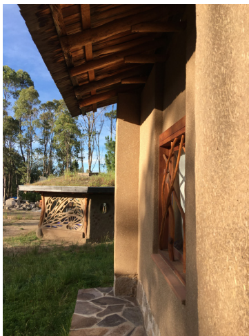
Figura 1: Revoques de tierra estabilizada con paja picada que permanecen a la intemperie sin presentar afectaciones. Proyecto San Isidro, diseñado y construido por la Arq. Alejandra Caballero en Tlaxco, Tlaxcala, México.
