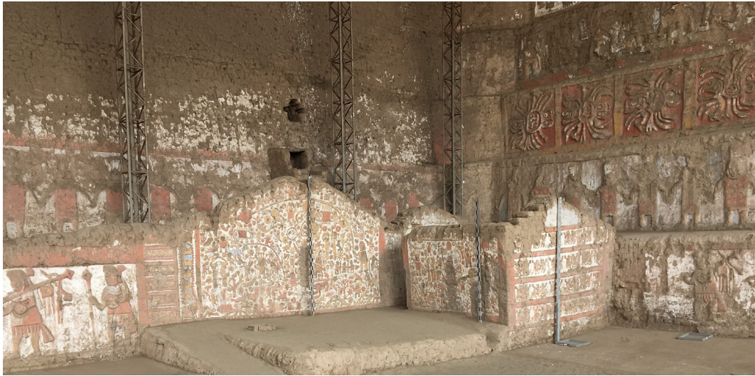
Figura 7: Los revocos realizados con tierra en las Huacas de Moche, Trujillo, Perú, se conservan con alto grado de integridad, a pesar de tener más de mil años de existencia
