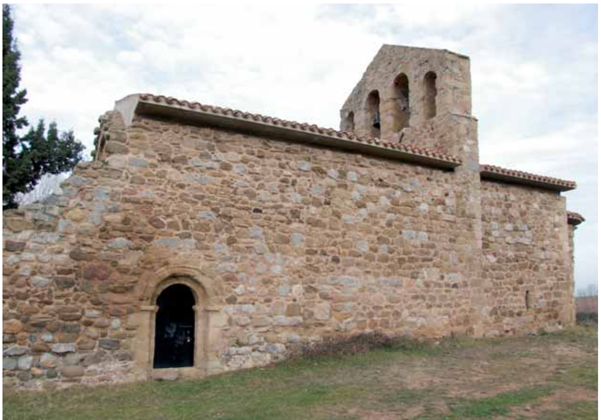
Muro sur y portada
