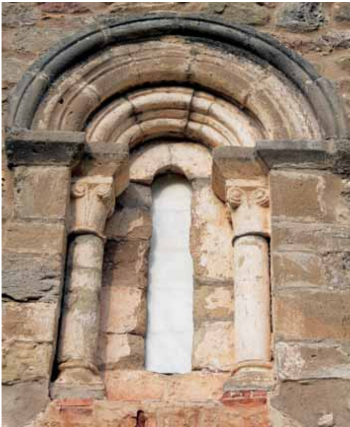
Ventana del hastial occidental
