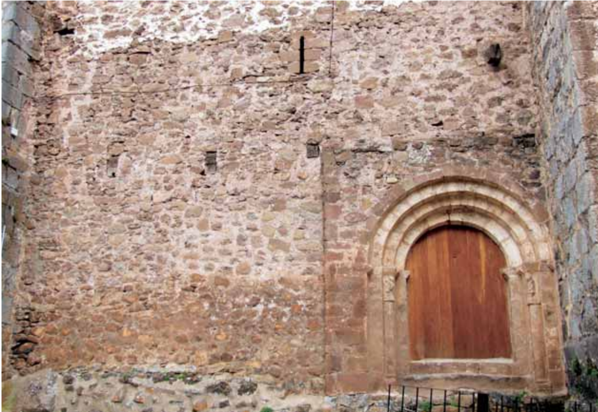
Portada en el muro norte
