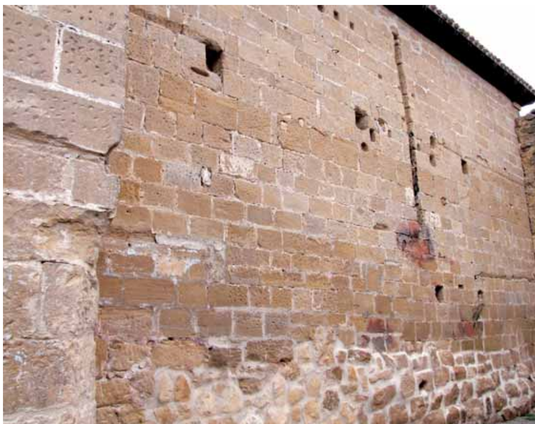
Exterior del muro norte de la nave de origen románico
