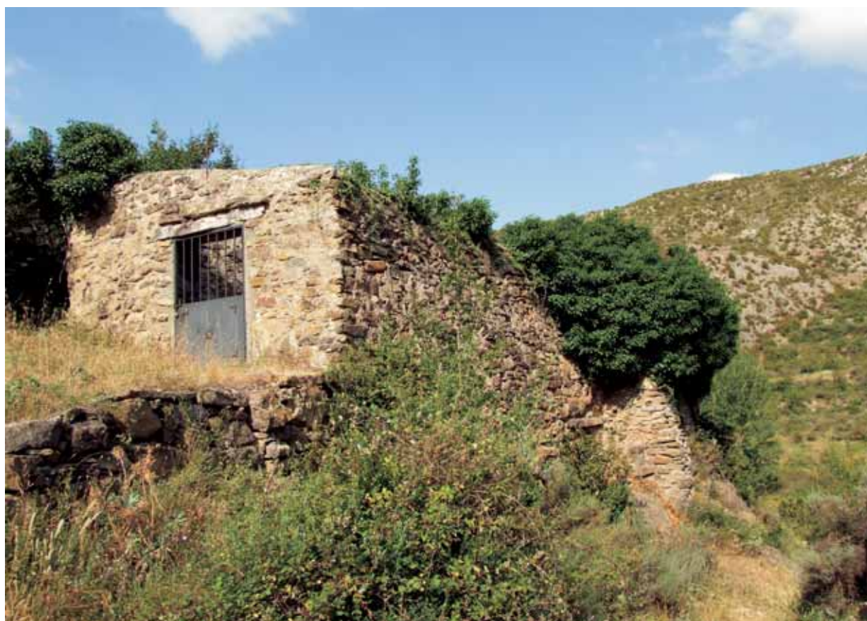
Exterior de las ruinas de la ermita de San Andrés
