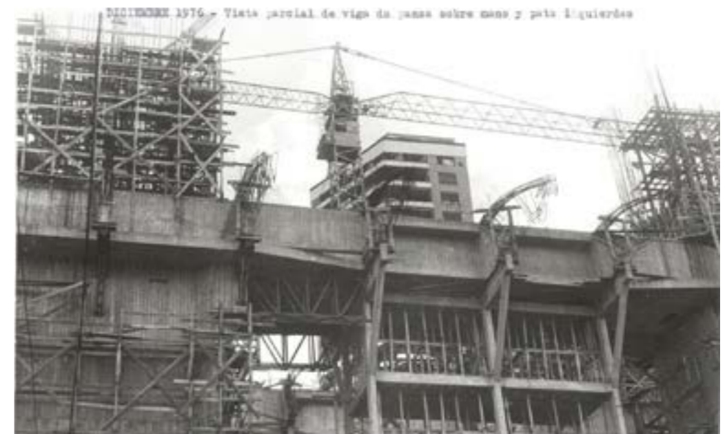
Figura 5. Los encofrados del hormigón armado de la biblioteca. En el acápite de la fotografía, las partes de la estructura se denominan "patas" y "barriga", como si de un ser vivo.
