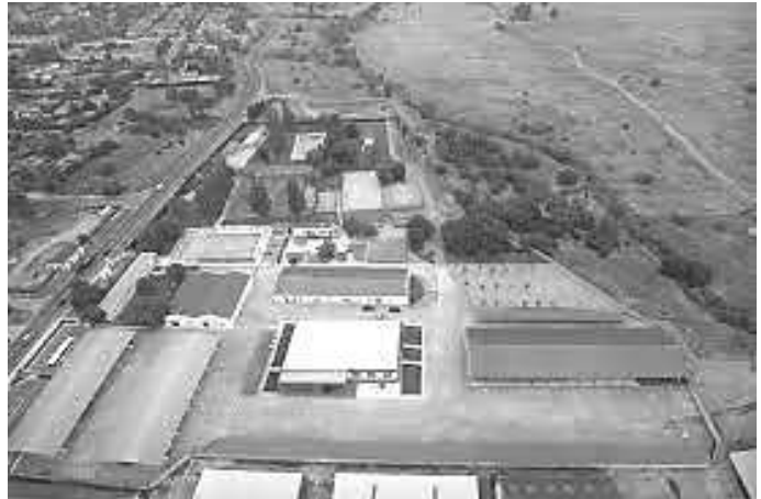
Vista aérea del Centro Sancha Brava desde el sur
