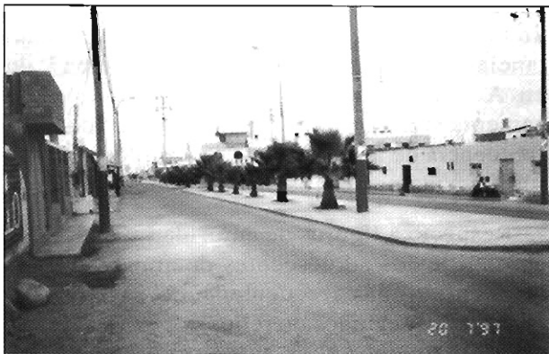
Figura 3.- ZONA NORTE. Vista de una de las calles. Se observa trazo urbano, pista asfaltada y servicio de electricidad.
